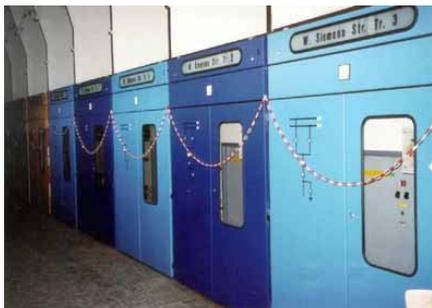
**Bild:** Farblich abgesetzte Schaltfeldtüren können Verwechslungen vorbeugen.
