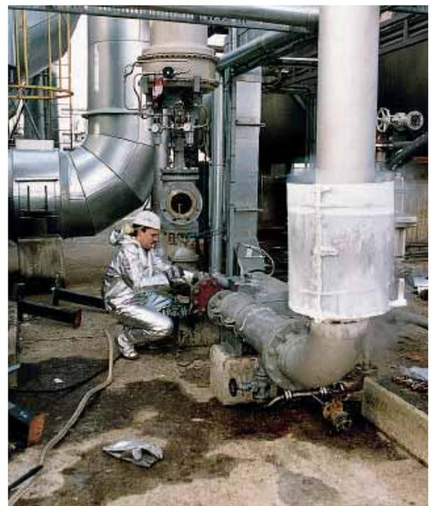
Rohrfrost nach dem „offenen Verfahren“ mit tiefkaltem verflüssigtem Stickstoff an einer senkrechten Rohrleitung (geschlossene Gefriermanschette) bei einer Fernwärmeerzeugungsanlage.
