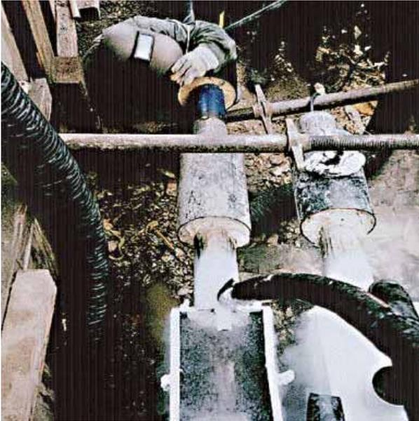
Rohrfrosten nach dem „offenen Verfahren“ mit tiefkaltem verflüssigtem Stickstoff an einer waagerechten Rohrleitung (offene Gefriermanschette) bei einer Fernwärmeverteilungsanlage.
