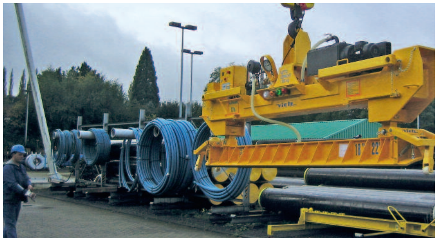
Sichere Verladung von Rohren auf einem Betriebshof: Die Vakuumhebeanlage (rechts) funktioniert, ohne dass der Mitarbeiter (ganz links) sich in eine gefährliche Situation begeben muss.
