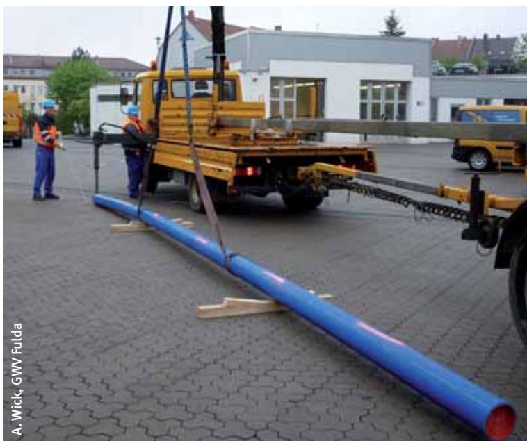
Abladen von PE-Rohren.
