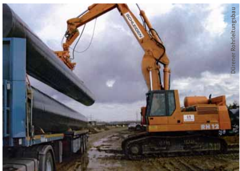
Vakuumhebergerät im Baustelleneinsatz.
