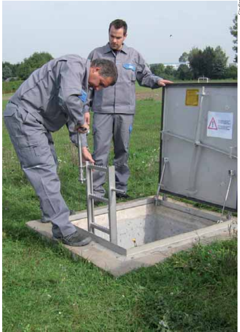
Die Einhausvorrichtung verhindert das unbeabsichtigte Zuschlagen des Schachtdeckels.
