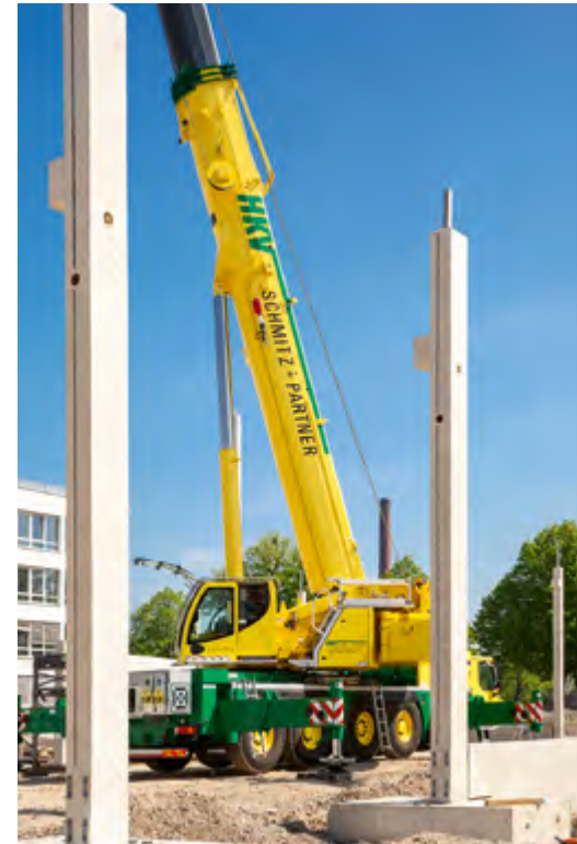
Die Position des Krans ist essenziell für sicheres Arbeiten. Unter anderem darf er nicht zu nah an der Kante der Baugrube stehen.
