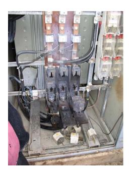
Bild: Arbeiten an NH-Verteilungen führen häufig zu Störlichtbogenunfällen.
