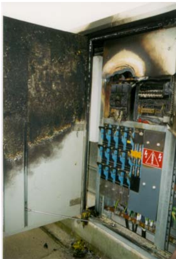
Bild: Plombierdraht löste Lichtbogen aus.
