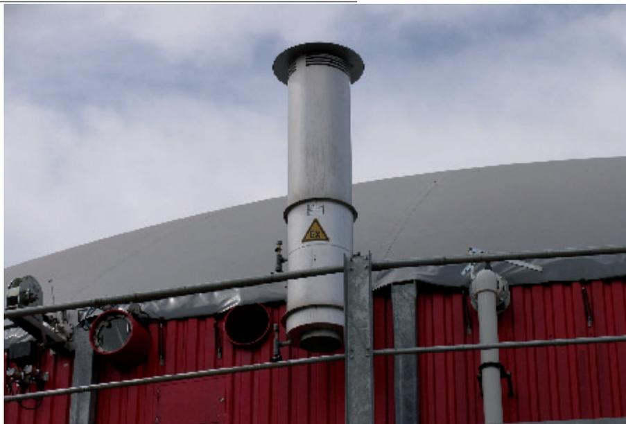
**Bild 2** Kennzeichnung explosionsgefährdeter Bereiche – Druckabsicherung.
