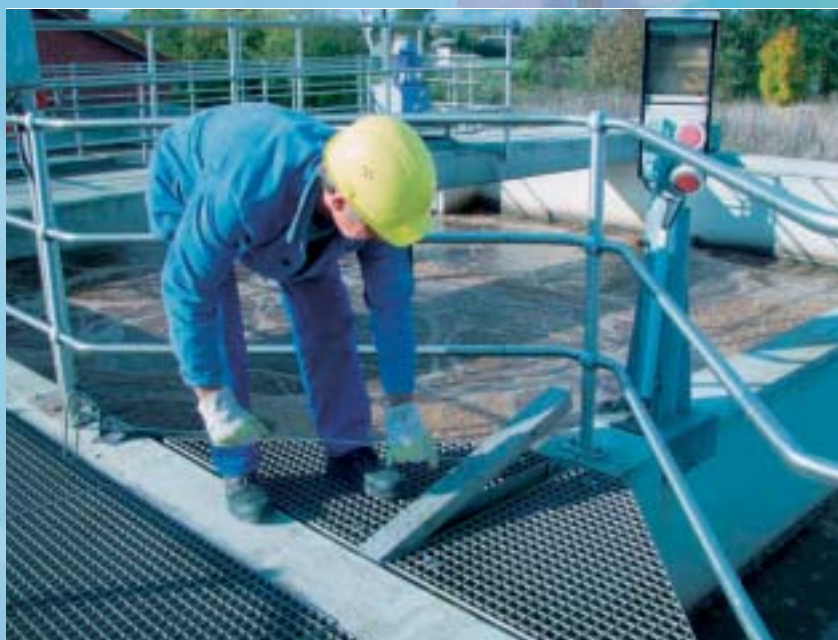
▲ Die Abdeckung liegt bündig auf, so dass keine Stolperstelle entsteht, und wird nur bei Bedarf entfernt
