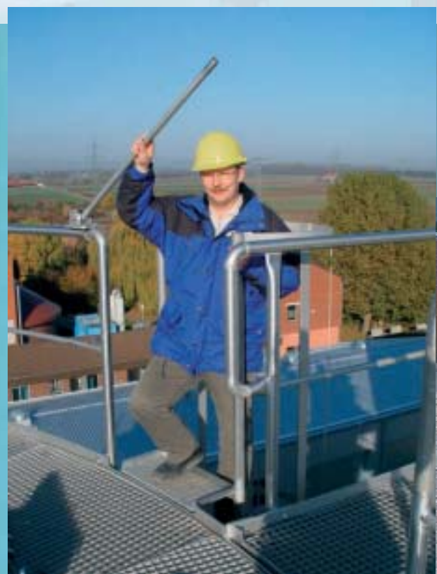
▲ Die klappbare Absturzsicherung am Zugang der Leiter wird nur für die unmittelbare Benutzung geöffnet
