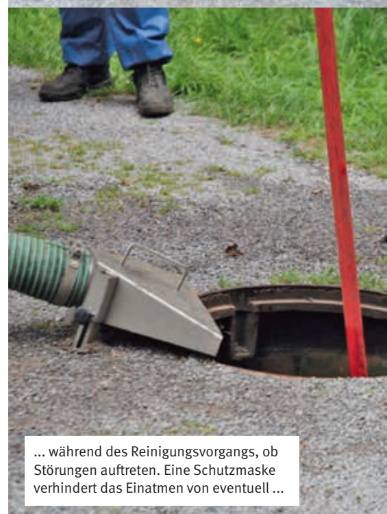
Die Reinigung von Asbestzementrohrleitungen in der Praxis: Ein Mitarbeiter des Kanalnetzes beobachtet ...
