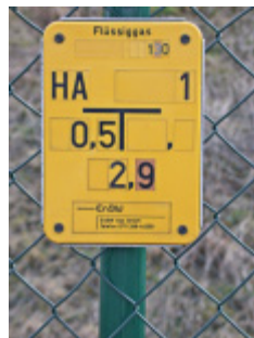
Abb. 4: Hinweisschild zur Lage eines Absperrschieber im Flüssiggasnetz
