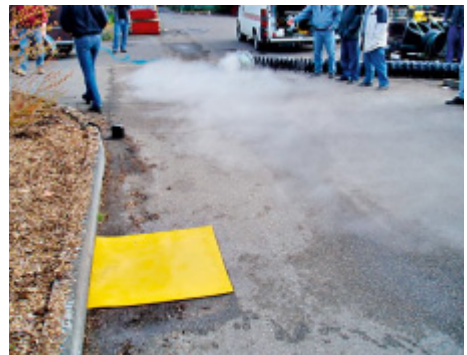
Abb. 8: Mit Matte abgedeckter Kanaleinlauf
