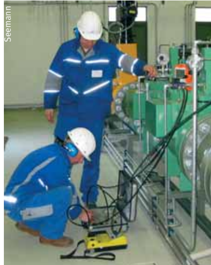
Bei Arbeiten in explosionsgefährdeten Bereichen, wie hier in Zone 2 einer Gasanlage, sind spezielle Schutzmaßnahmen zu treffen.
