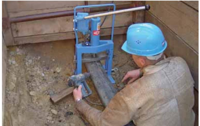
Auch bei Arbeiten mit geringer Gefährdung besteht Brand- und Explosionsgefahr. Deshalb muss auch eine Aufsicht vor Ort sein. Hier zum Beispiel nach dem Quetschen einer Gasleitung.
