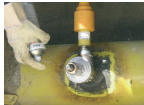
Dichtheitsprüfung unter Verwendung schaubildender Mittel
