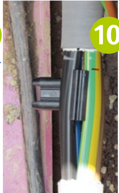
Fixierkeil und Querkeile zwischen die gespreizten Adern einbringen
