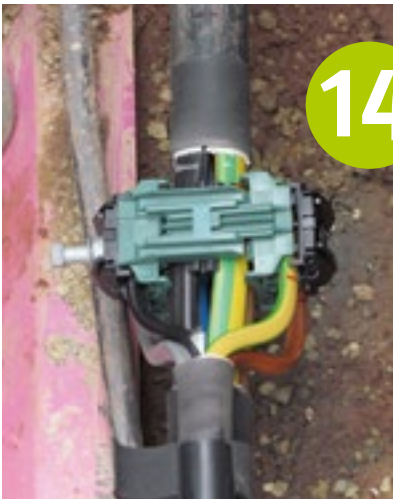
Die Deckel in die Gehäusehälften einrasten, dabei die Montageschraube durch den Fixierkeil führen
