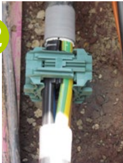
Zwickelschnur durchtrennen und entfernen (Bild zeigt Hilfswerkzeug zum Herausführen der Zwickelschnur)
