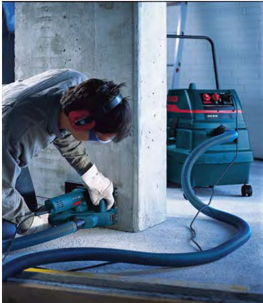
Bild 4: Mauernutfräse und Entstauber
