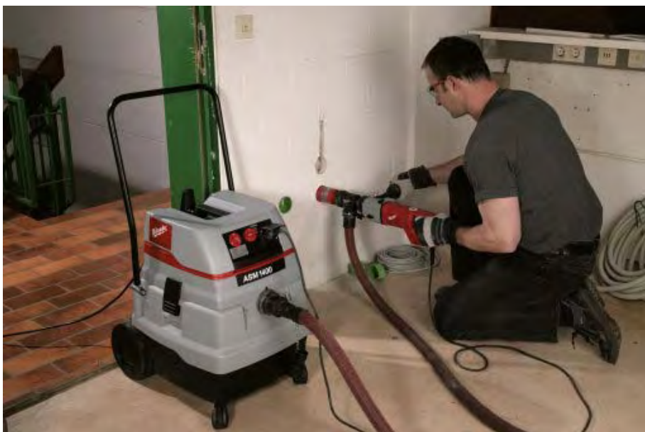
Bild 11: Dosensenken mit Absaugung
