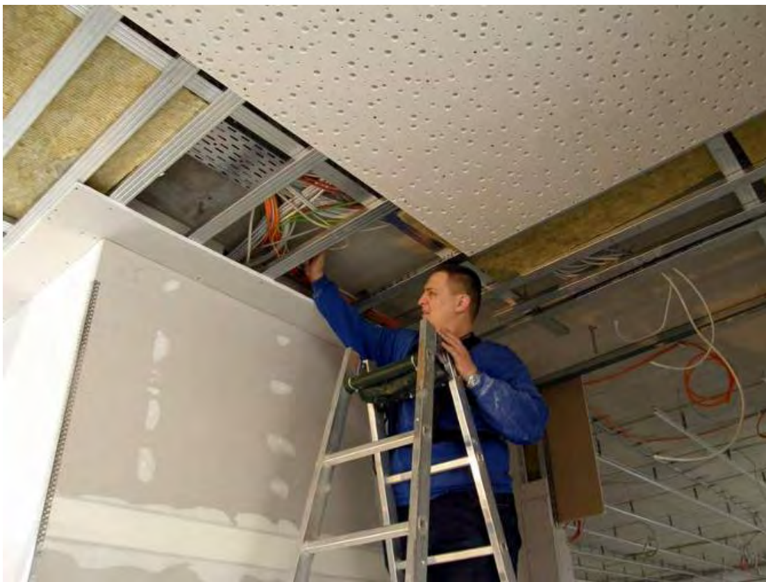
Bild 13: Verlegen von Leitungen
