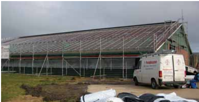
Bevor die Photovoltaik-Anlage montiert wurde, ist ein Fanggerüst mit einem über den Arbeitsbereich hinausreichenden Fangnetz eingerichtet worden.
