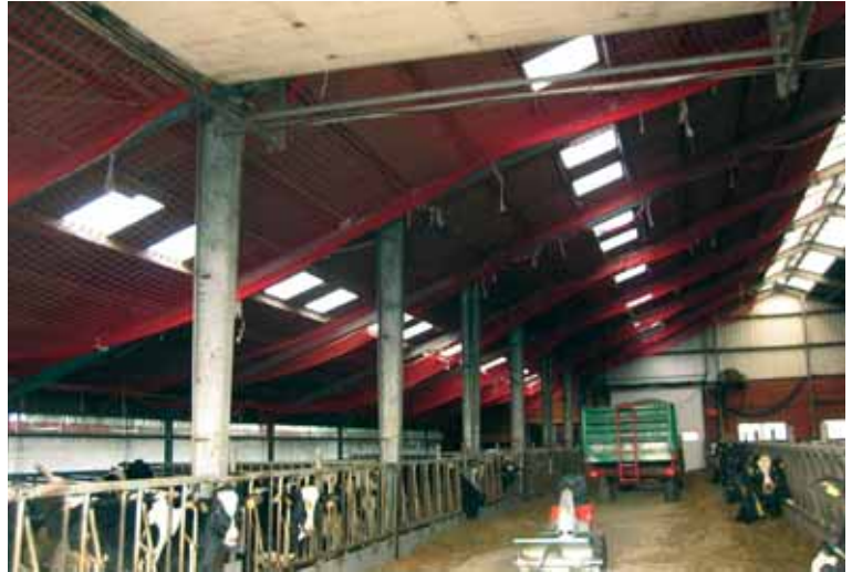
Die nicht durchtrittsicheren Lichtelemente wurden im Arbeitsbereich der Monteure mit Auffangnetzen unter dem Dach gesichert.
