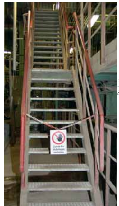
Beispiel für den Einsatz einer Absperrkette mit Sicherheitskennzeichnung. Liegen oberhalb des Zugangs unmittelbare Gefährdungen vor, ist eine Absperrung mittels Kette unzulässig.
