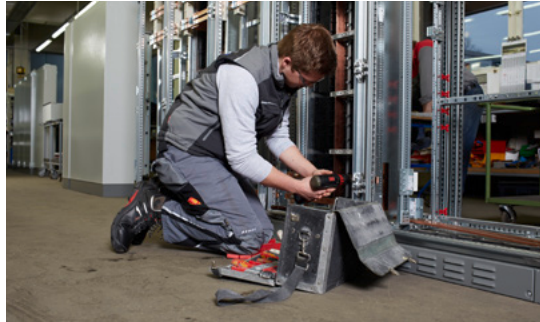
Arbeiten an elektrischen Anlagen
