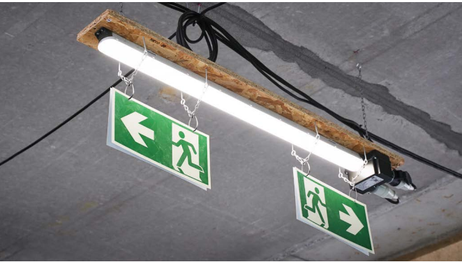
Beispiel einer batteriegepufferten Baustellenleuchte, mit der eine dauerhafte Beleuchtung der Baustellenbereiche sichergestellt werden kann.
