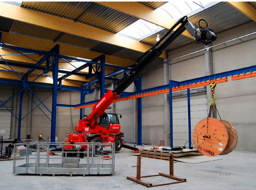
Einsatz eines Teleskopstaplers als Mobilkran
