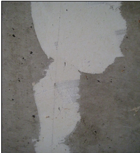
Asbesthaltige Spachtelmasse
