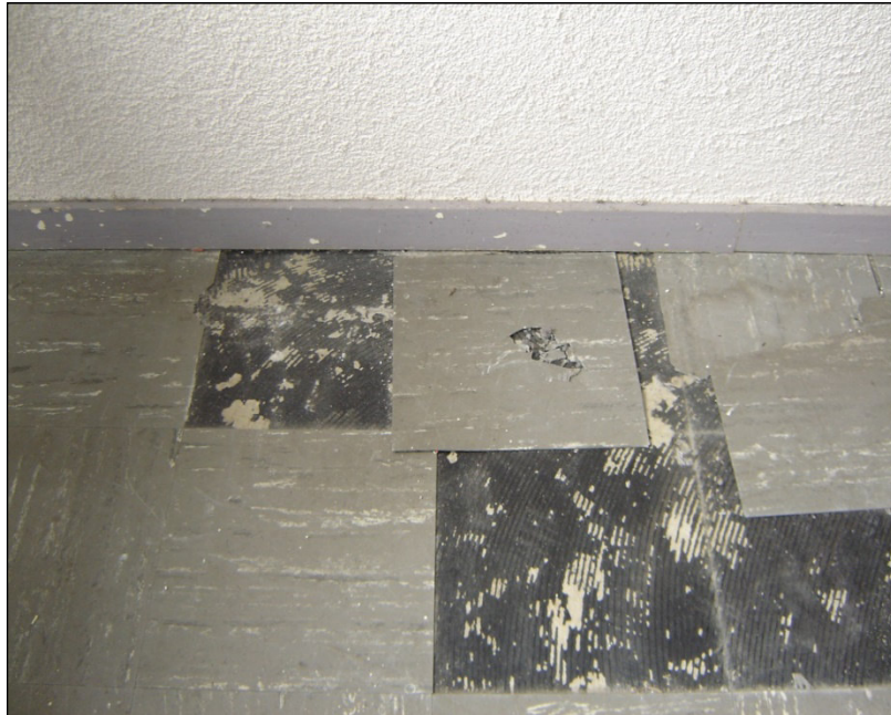
Asbesthaltige Bodenbeläge und Kleber
