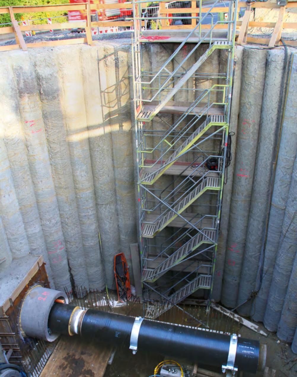
Für die teilweise im Pressverfahren gebaute Fernwärmeleitung mussten Pressschächte erstellt werden.
