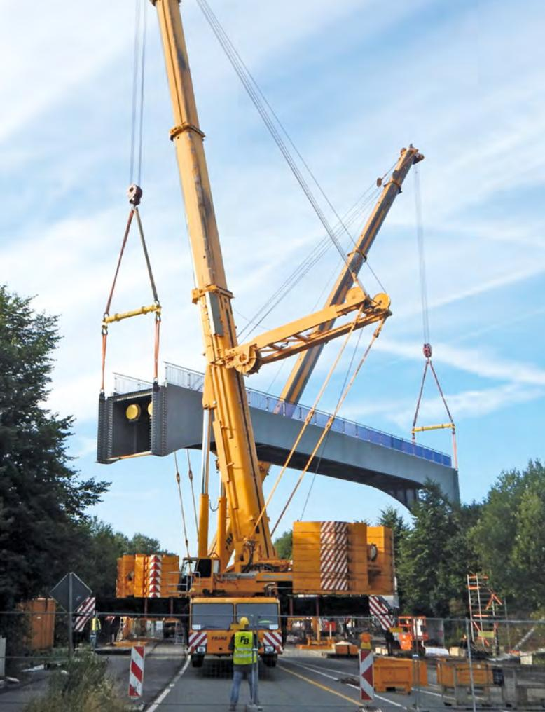
In diesem Teil der Trasse wurde die neue Fernwärmeleitung im Unterbau einer Brücke verlegt (gelbe Schutzkappen sind sichtbar).
