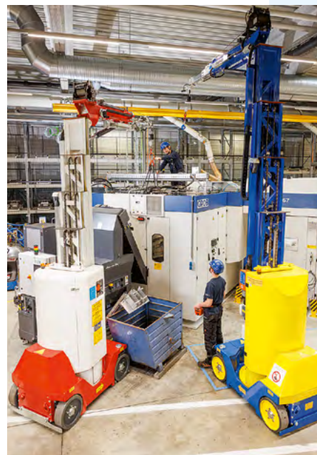
Bei der Reparatur großer Maschinen kommen zum Teil auch aufwendige Hilfsmittel zum Einsatz.
